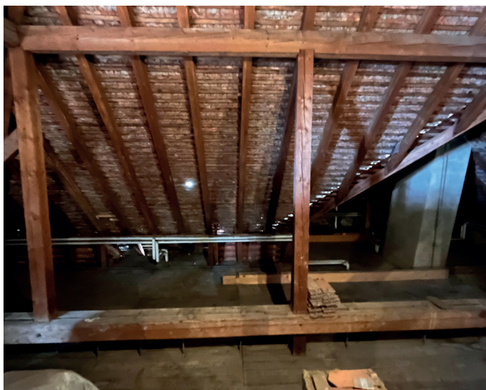
Dach Untersicht vor Sanierung
