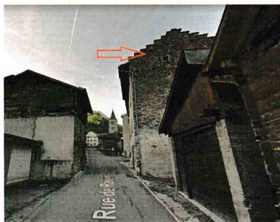
Façade nord (googlemaps, 2013)
