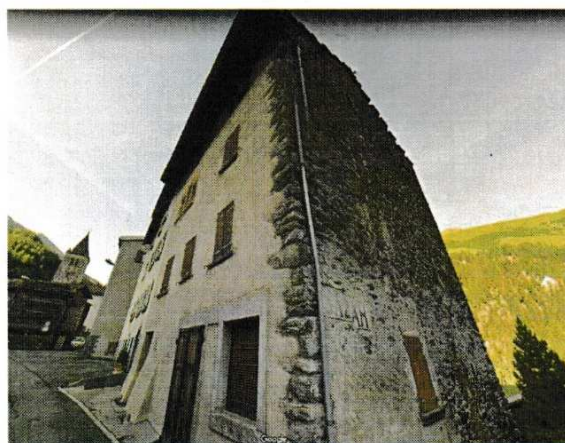
Façades nord et est (googlemaps, 2013)
