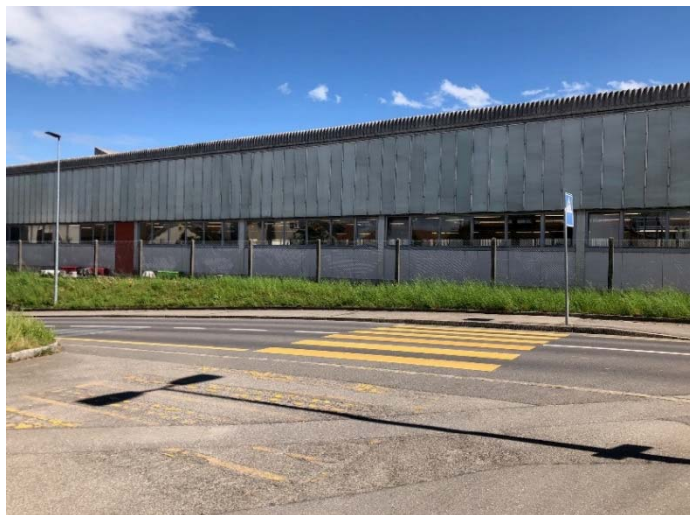
Passage pour piétons existant
