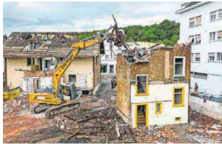
Mit dem Greifer wird das Haus zerlegt.
