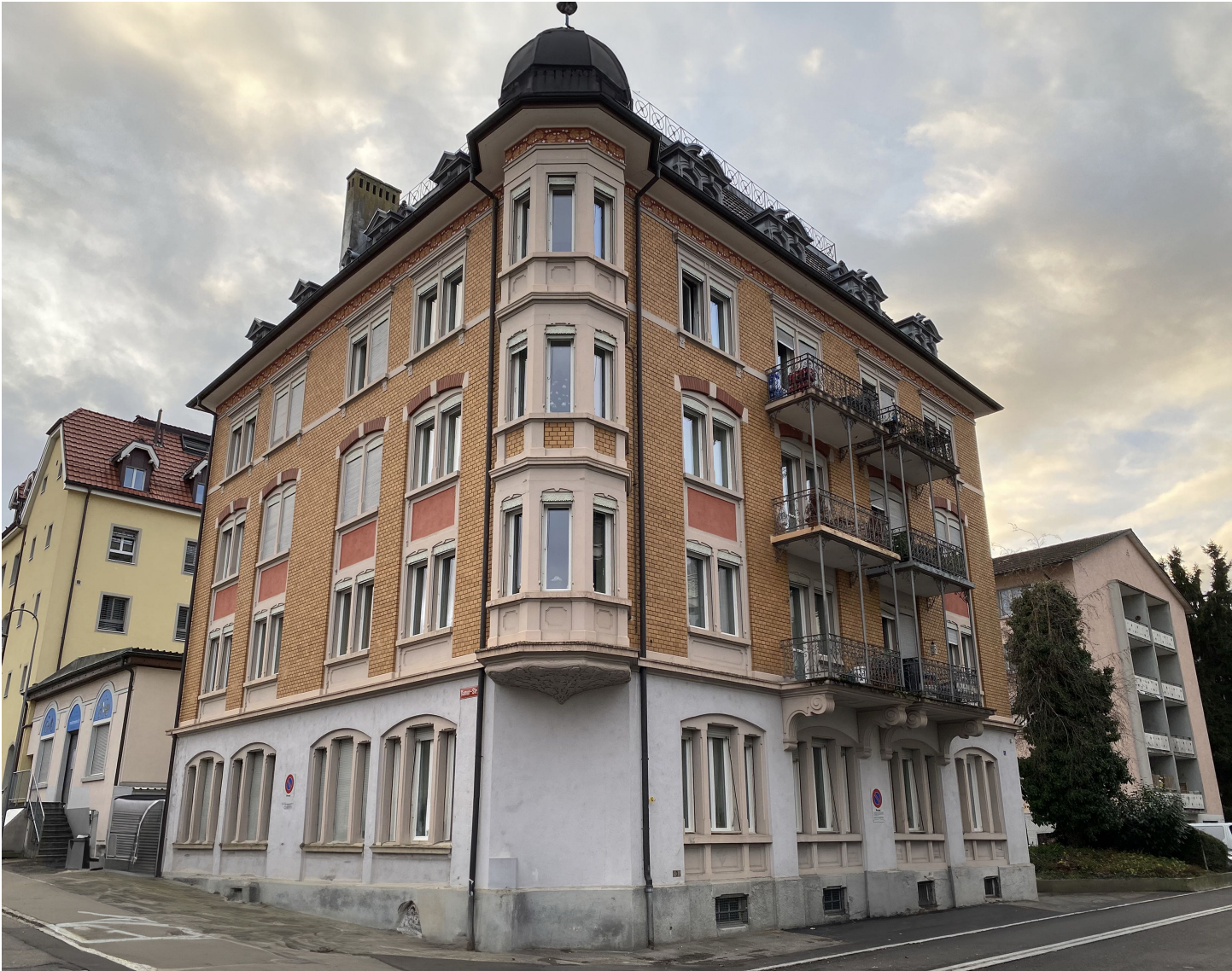
Klassisch gegliederter Baukörper mit Sockel, Schaft und Dach, vertikale Fensterachsen Löwengartenstrasse 9 Rorschach
