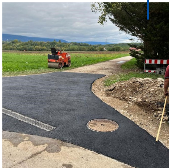
Croisement des chemins des Crêtes et des Cressonnex.
