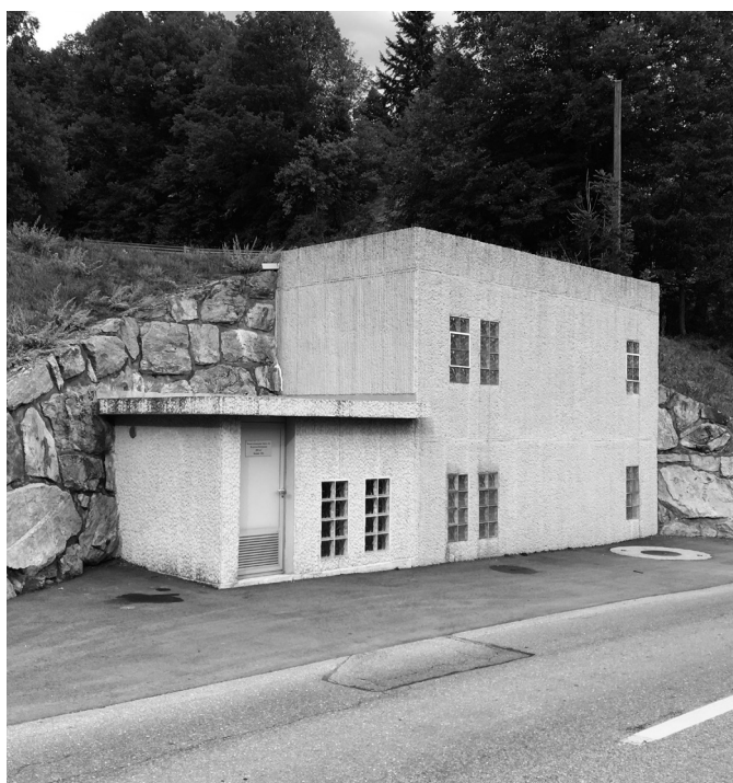
Aussenansicht des Reservoirs «Chilchmatta»
