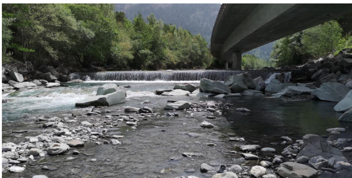
Abbildung 3: Schwelle Cumparduns und Brücke N13, Blick gegen die Fliessrichtung, Juni 2021
