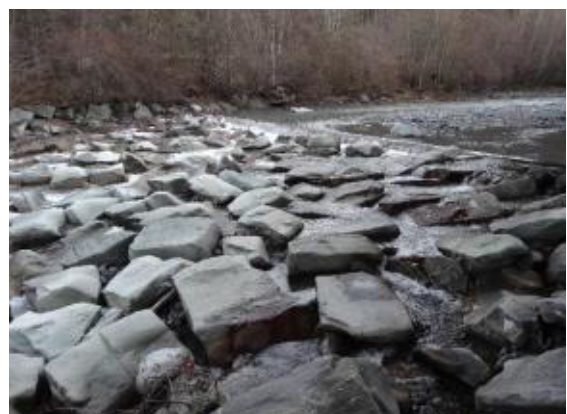
Abbildung 9: Schwelle mit vorgelagerter Blockrampe, Blick gegen die Fliessrichtung (Photo: Dezember 2015, hzp [9])
