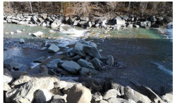
Abbildung 11: rechtes Ufer direkt unterhalb Schwellen, Reste von kollabierter Blockrampe in der Sohle ersichtliche (Januar 2024)
