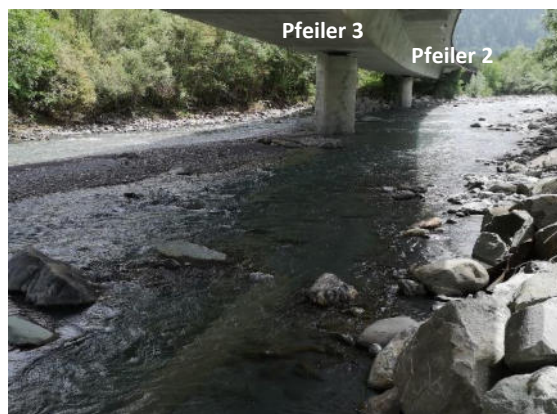
Abbildung 8: N13-Brücke über den Hinterrhein, Blick gegen die Fliessrichtung, Juni 2021
