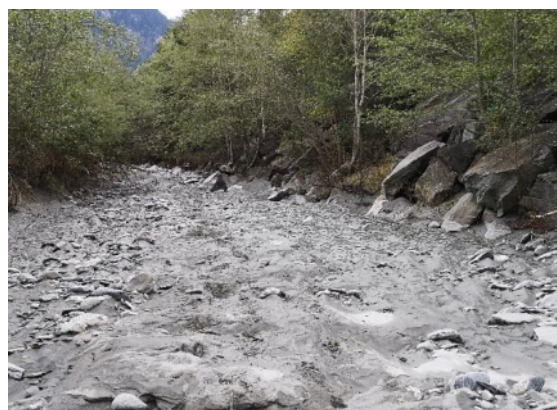
Abbildung 29: Linksseitiger Blocksatz Altarm und Feinsedimentablagerungen durch Hochwasser August 2023, Blick gegen die Fliessrichtung
