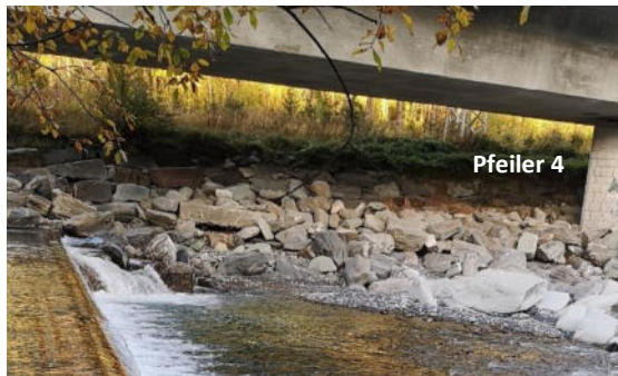
Abbildung 10: Schwelle, Blicke auf das linke Ufer und N13 Pfeiler 4
