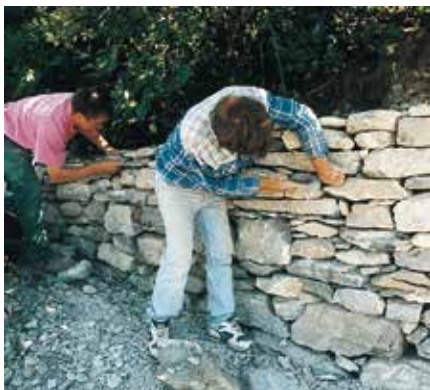
Wiederaufbau der Trockensteinmauern
