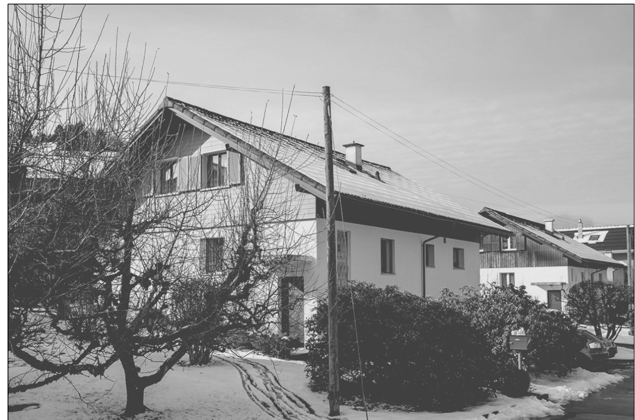
Fassadenansicht Nord & Ost I 26.02.2023
